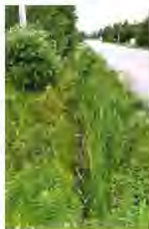
Photographie no 4: La protection des lacs et des cours d'eau naturels commencée loin en amont dans le bassin versant. Les fossés routiers constituent certainement l'un des éléments importants de la problématique, mais il en va de même de nos attitudes et de nos attentes en matière de drainage routier. Il faut à tout prix changer notre conception d'un fossé 'propre' et s'habituer à y voir une végétation luxuriante. (Photo: RAPPEL, 97-07-07)
